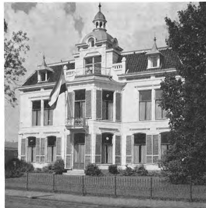
Bureau „Opbouw Drenthe” en D.E.T.I.
